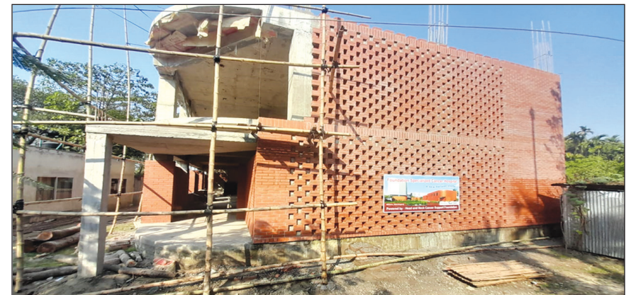
Construction progress till date
